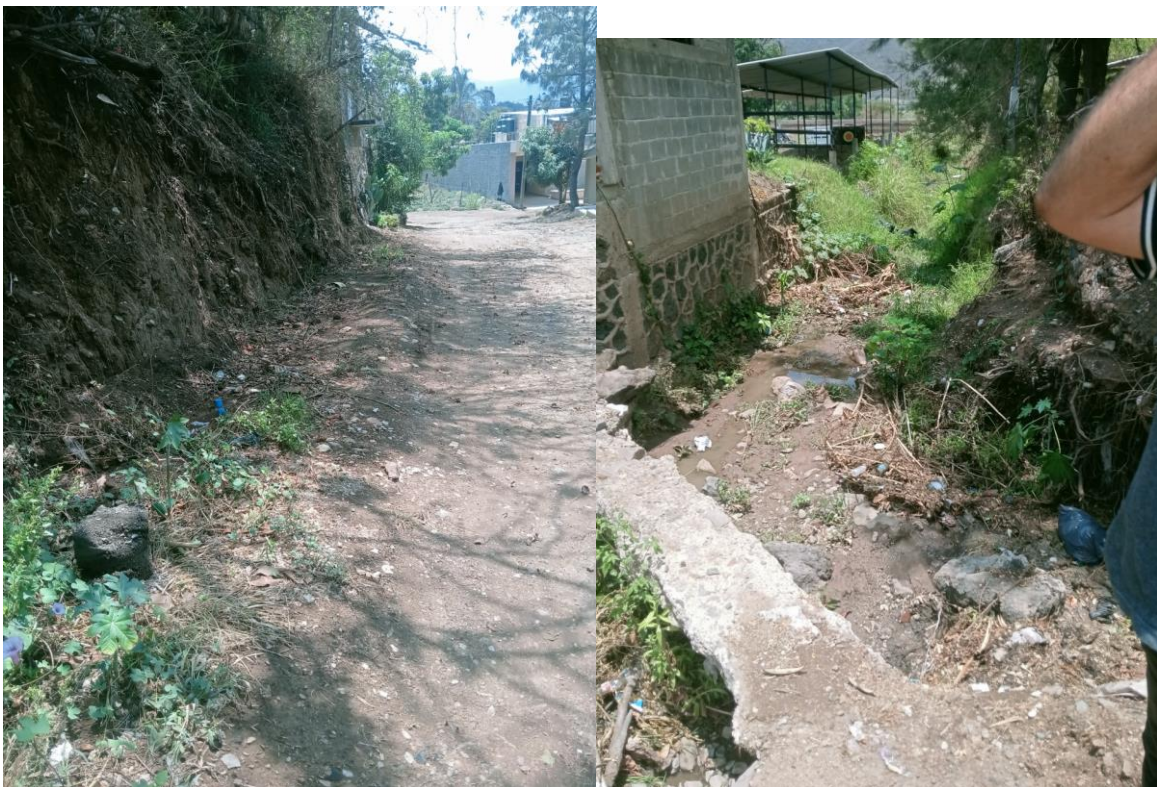
Apoyo con material para retención de tierra con un muro perimetral.
