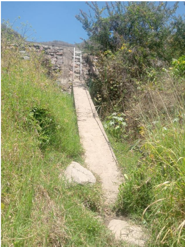
Visita de accesos para futuras obras en la colonia San Juan Bosco.
