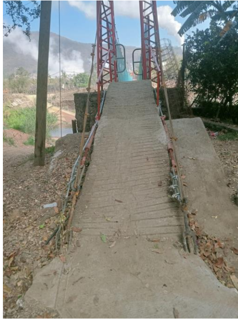
Reparación de acceso y rampa del puente San Antonio.
