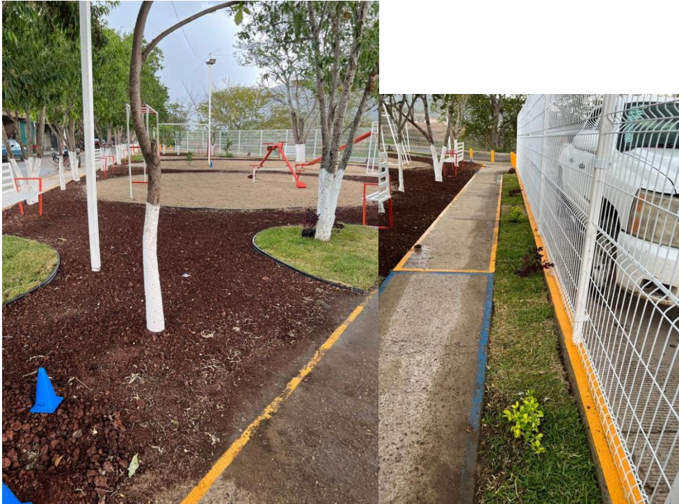
Pinta de árboles y arreglo de pasto en parque Alamo.
