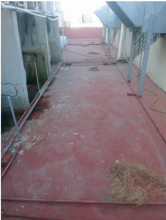
Supervisión de impermeabilizante del mercado municipal.
