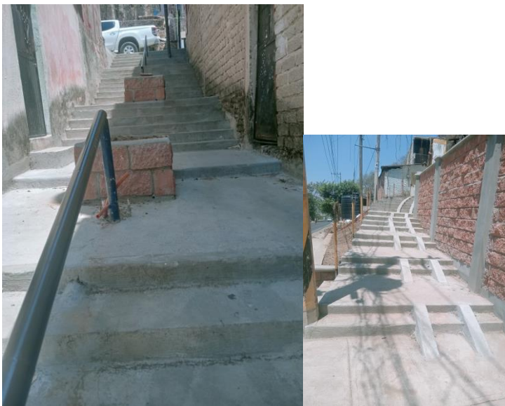
Inspección del trabajo de graderías en la colonia de Clavellinas.
