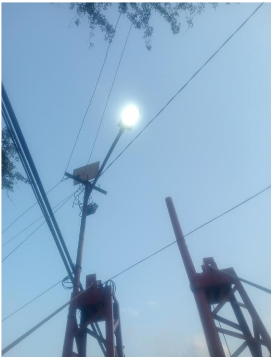
Inspección de alumbrado público en el puente peatonal de San Antonio.
