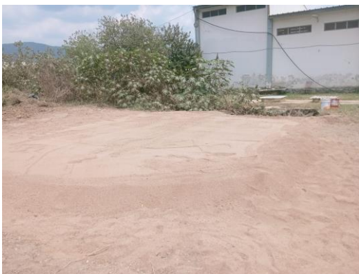
Preparación de plancha para la instalación de una geo membrana en el rastro municipal.
