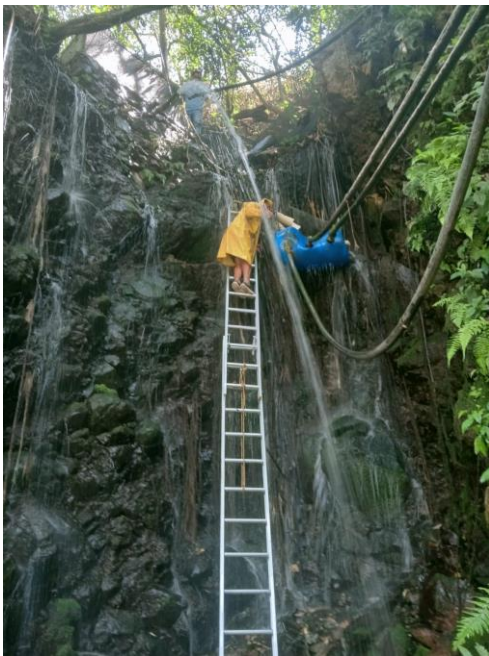
Mantenimiento del manantial que abastece de agua a la delegación de Contla.
