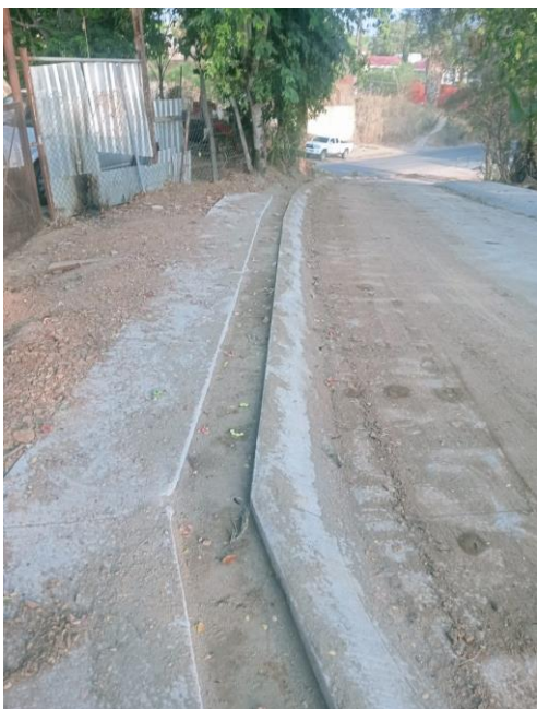
Supervisión de obra línea de agua en la calle Luis Donaldo Colosio de la cabecera municipal.
