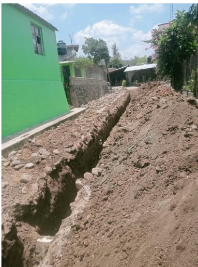
Sustitución de línea de drenaje en la comunidad de Apatzingan.
