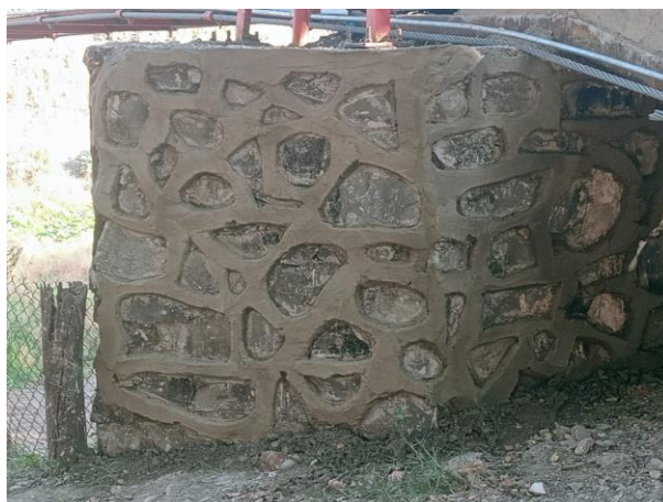
Reestructuración y remodelación de muros del puente de San Antonio.
