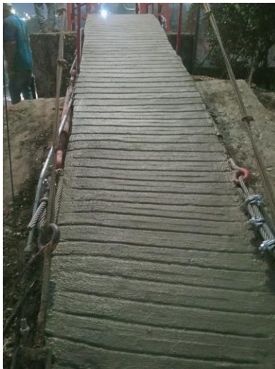
Inspección de gradería Morelos y carretera Jiquilpan Manzanillo.
