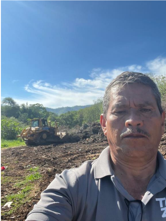
Cobertura del relleno sanitario y arreglo de caminos de acceso.
