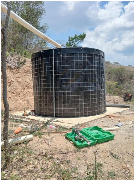
Instalación de membrana de 20,000 litros en la agencia de los Rusios.
