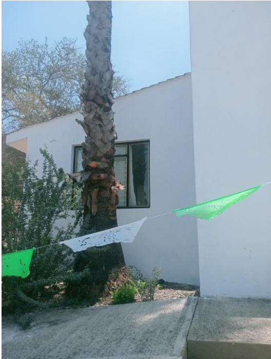
Inspección de la obra de rehabilitación del centro de salud de la comunidad de Arroyo Hondo.
