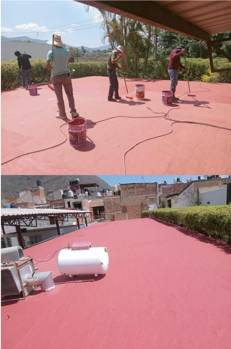
Inspección de trabajo de impermeabilización en el DIF municipal.
