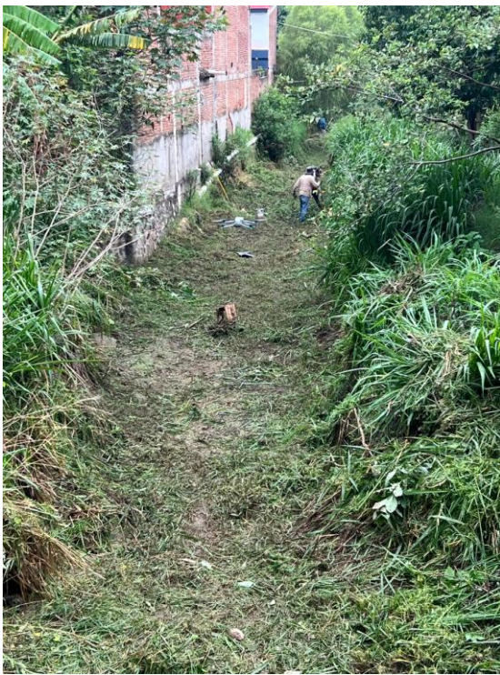
Limpieza del arroyo el platanar en el municipio de Tamazula de gordiano.
