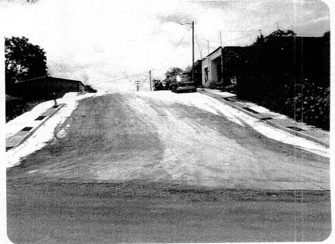
La construcción de pavimentación de la calle Mariano Becerra de Vista Hermosa, con concreto hidráulico, machuelos, banquetas, línea de agua y red de drenaje sanitario, con una inversión de **\$4'718,276.46** pesos.
