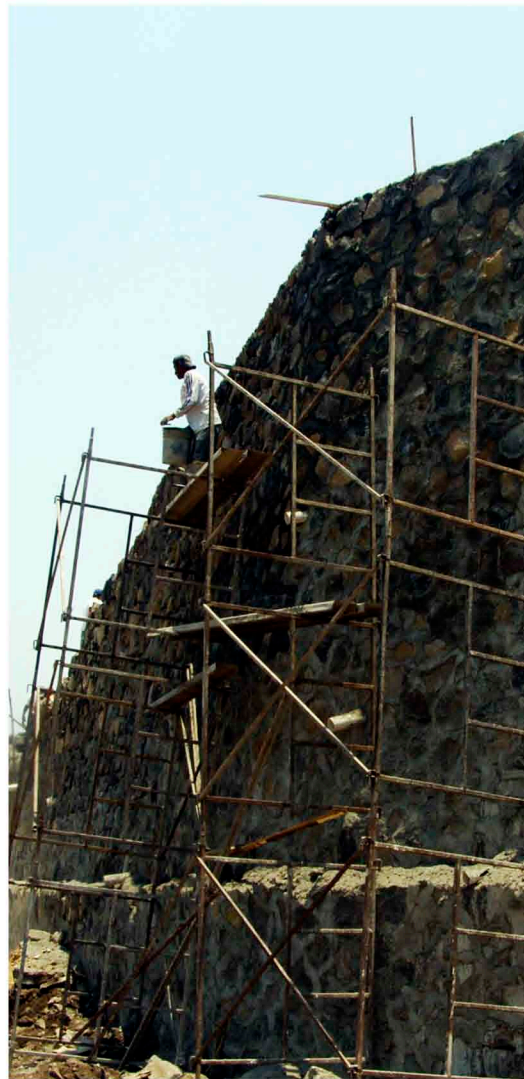
Muro de Contención del Centro de Convenciones
